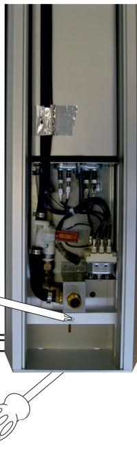
För in en skravmejsel under pelaren så att den ligger tryckt mot taket. Skruva sedan fast pelaren nedtill.
